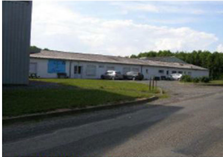
Vue sur bâtiment bureaux
